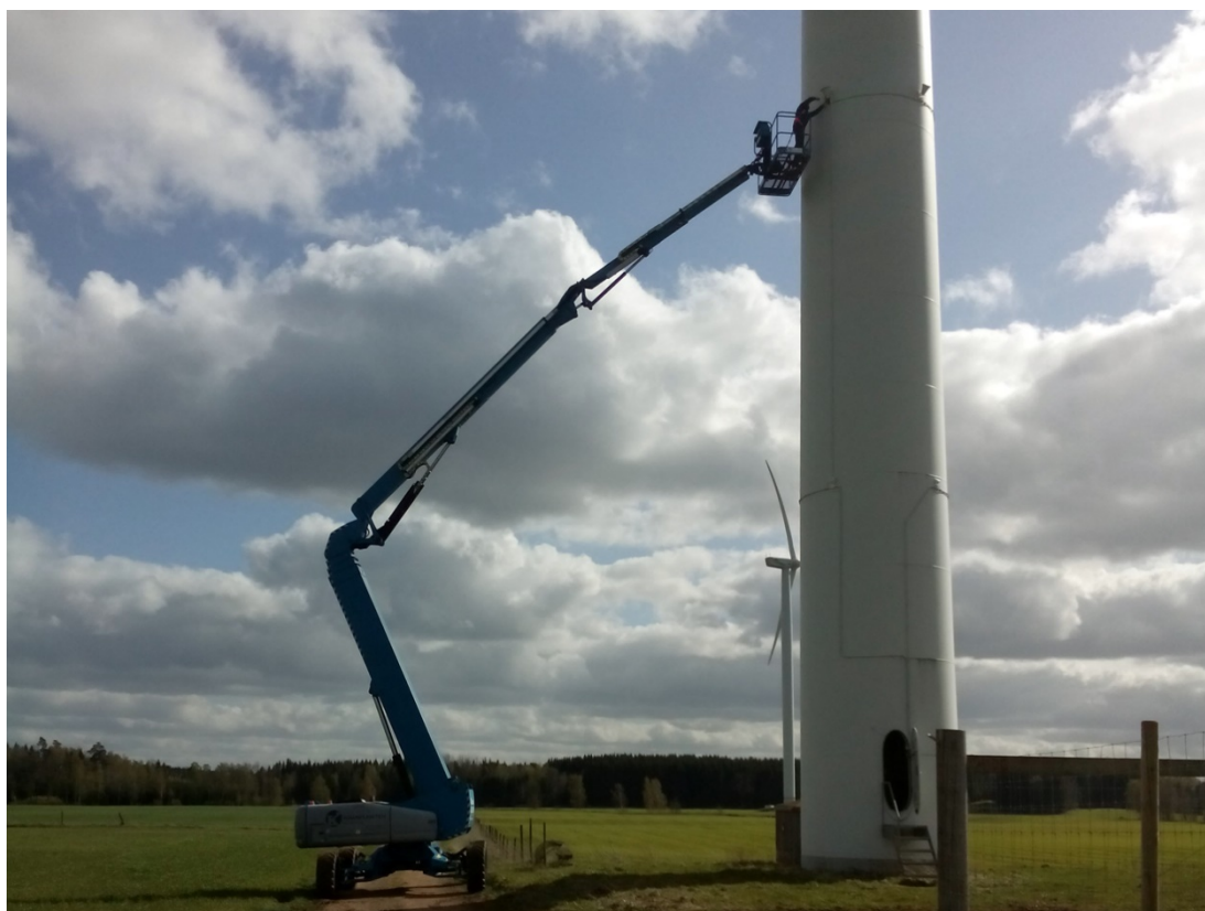
Figur 12. Montering av DTBird-systemet. Beroende på vilka vinklar som är viktigaste att filma och för att begränsa ljudspridningen kan man välja att installera högtalare och kameror på olika höjder. Foto: Tore Wizelius.
